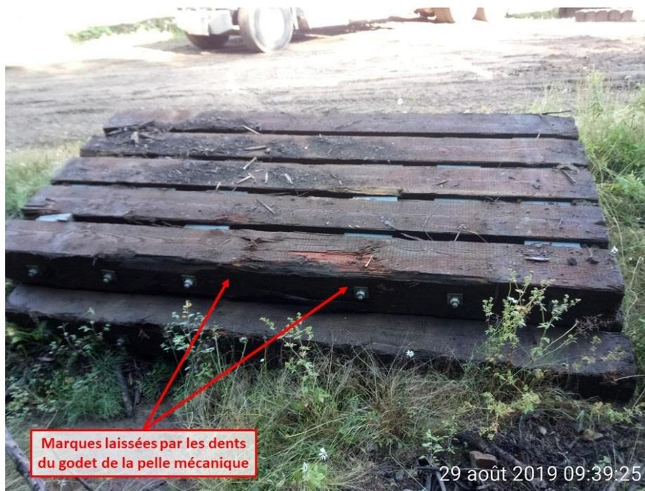
**Figure 3.5.8 : Élément de tablier endommagé par le godet de la pelle mécanique lors du démontage des éléments de tablier de conception – Site T004-03 (29 août 2019, Lanaudière).**
