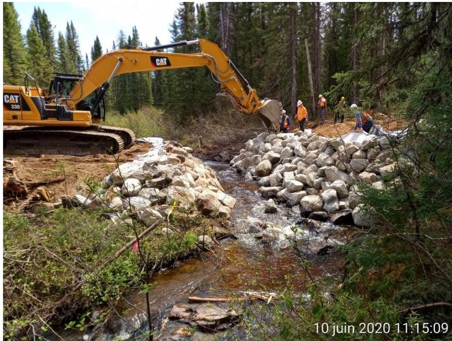
**Figure 3.5.3 : Remblai de nivellement – Site Chantiers Chibougamau (10 juin 2020, Nord-du-Québec).**
