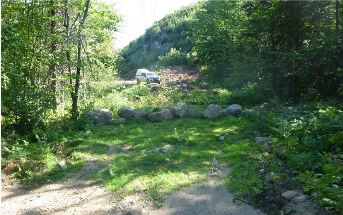
**Figure 3.2.3 : Stabilisation des surfaces exposées à l'érosion et établissement d'un couvert végétal de protection des sols (2 mois après démantèlement) – Site T425-1 (20 août 2019).**
