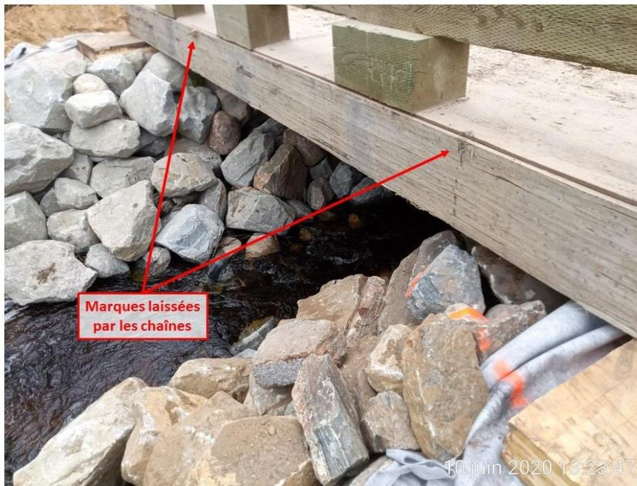
**Figure 3.5.7 : Usure inévitable des éléments de tablier de conception lors du montage – Site Chantiers Chibougamau (10 juin 2020, Nord-du-Québec).**
