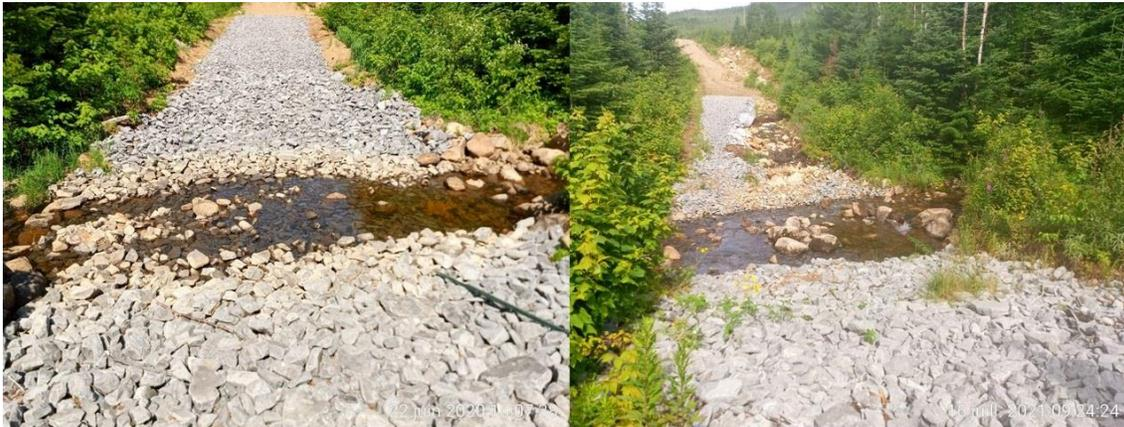
**Figure 4.3.4 : Dommages engendrés par la défaillance des structures de drainage du chemin en approche de la TAGE – Site Perdu (22 juin 2020 (gauche), 16 juillet 2021 (droite), Capitale-Nationale).**
