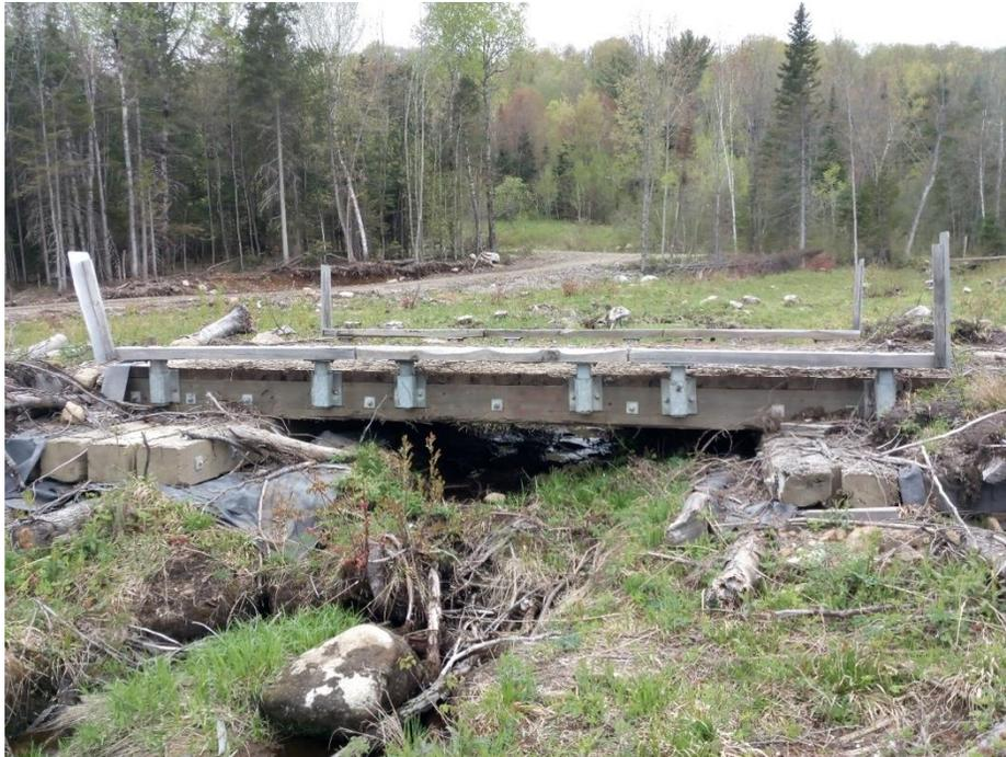
**Figure 3.5.5 : Éléments d'appui de conception constitués de poutres de bois interreliées (matelas-culées) et coussins de nivellement constitués de matériel granulaire et de radiers de bois - Site 428-7 (28 mai 2019, Lanaudière).**
