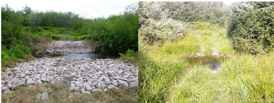
**Figure 4.3.6 : Construction de la TAGE (gauche) et deux années après (droite) – Site 10 (21 juin 2019 et 12 août 2021, Côte-Nord).**
