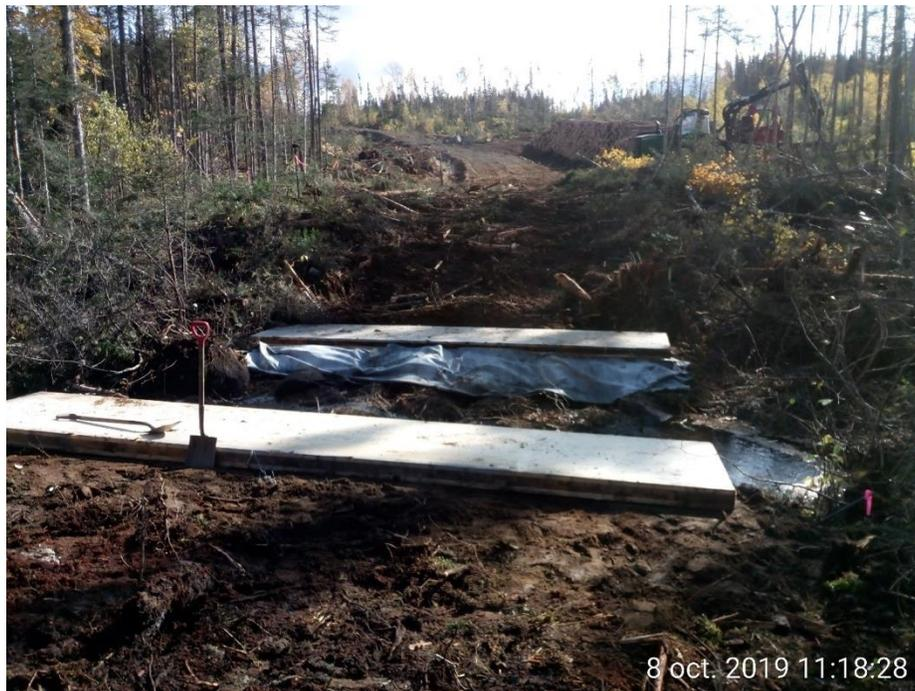
**Figure 3.5.4 : Coussins de nivellement constitués de matériel granulaire et éléments d’appuis de conception constitués de bois lamellé-collé (matelas-culées) – Site Boisaco (8 octobre 2019, Côte-Nord).**
