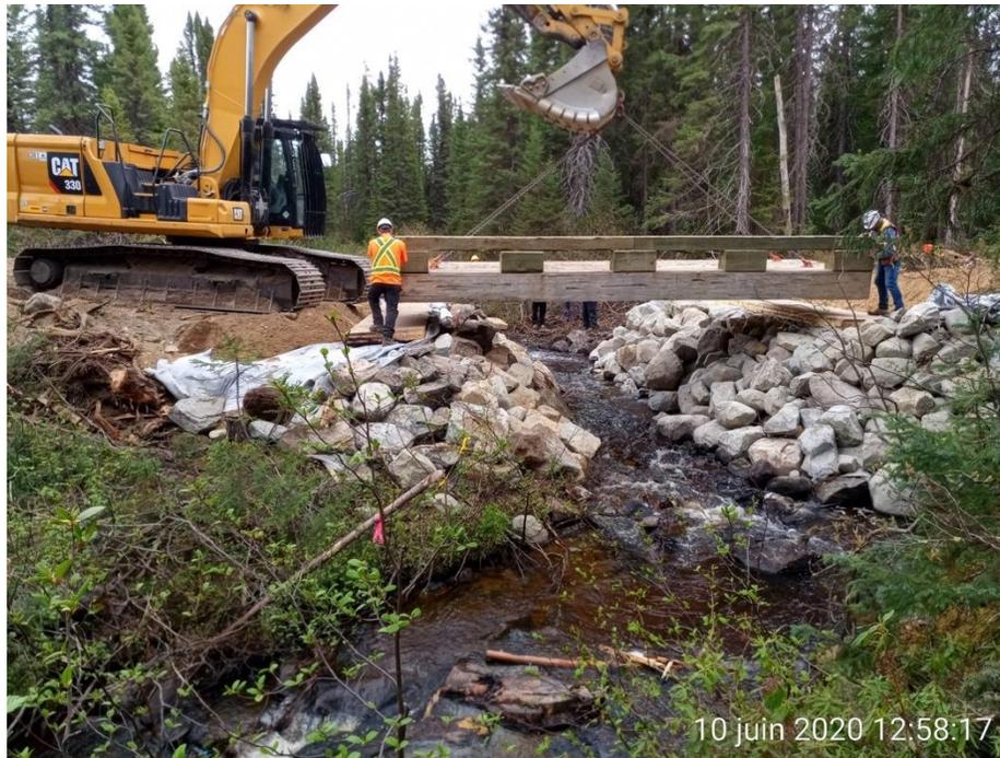
**Figure 3.5.6 : Montage des éléments de tablier – Site Chantiers Chibougamau (10 juin 2020, Nord-du-Québec).**
