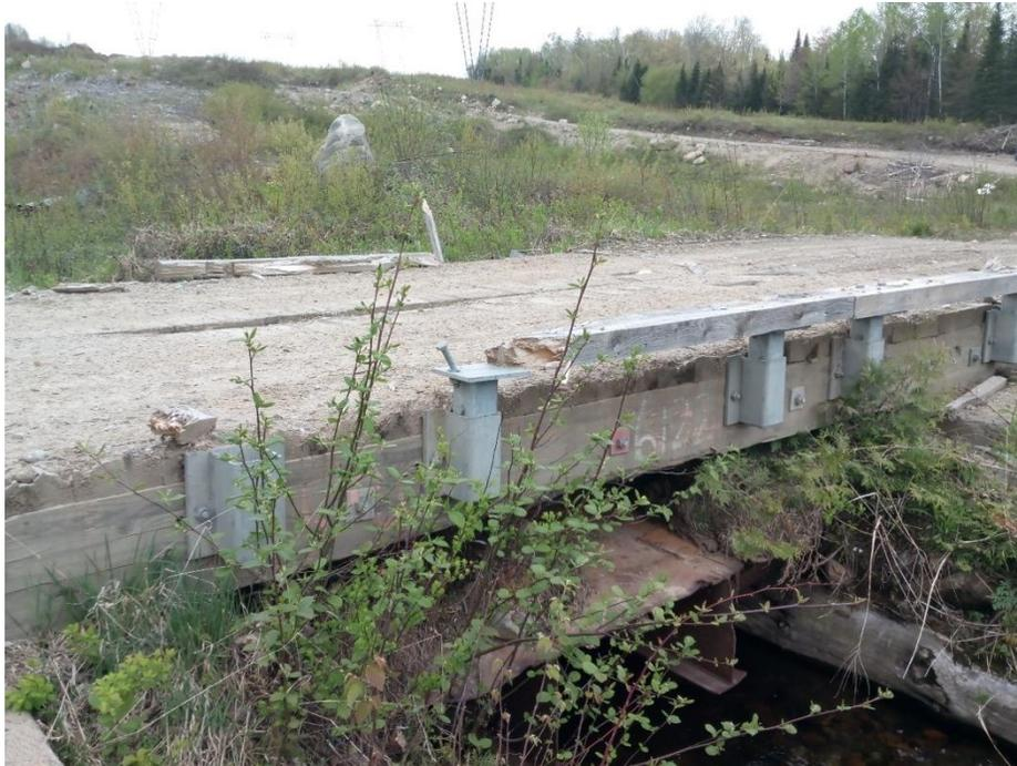
**Figure 3.5.9 : Garde-roues endommagés par la machinerie lors des interventions de déneigement du chemin – Site 428-6 (28 mai 2019, Lanaudière).**
