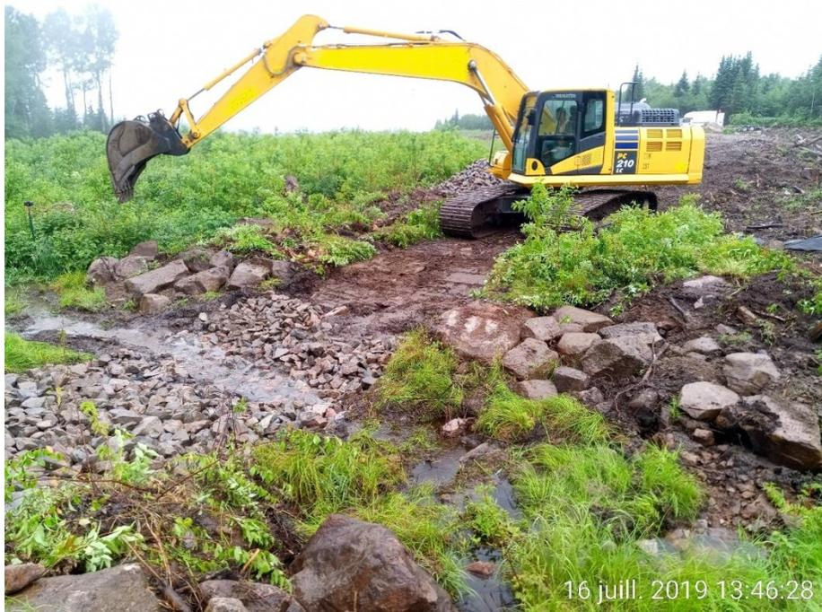
**Figure 4.3.3 : Stabilisation des berges et du lit du cours d'eau – Site T18-2 (16 juillet 2019, Mauricie).**
