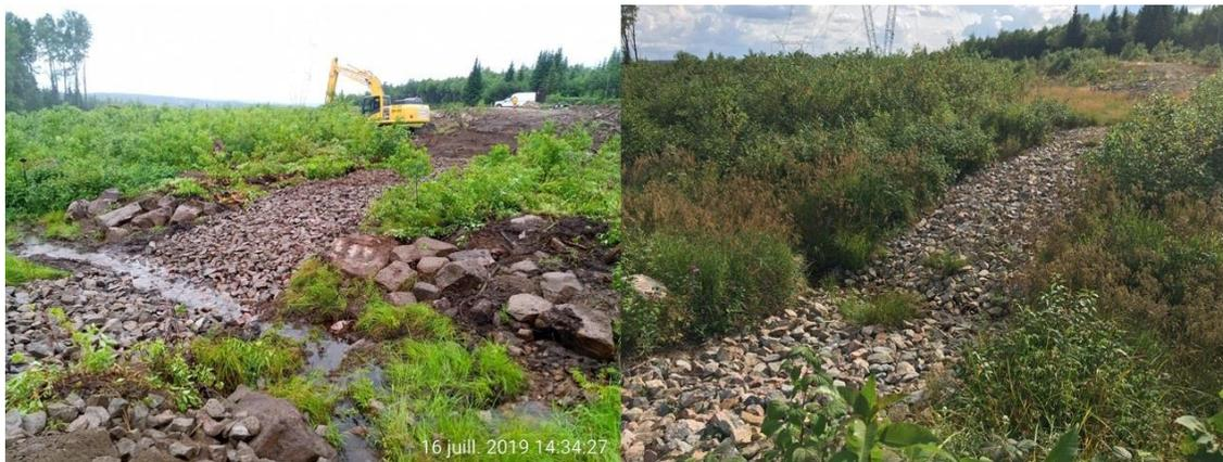
**Figure 4.3.5 : Construction de la TAGE (gauche) et deux années après (droite) – Site T18-2 (16 juillet 2019 et 13 août 2021, Mauricie).**
