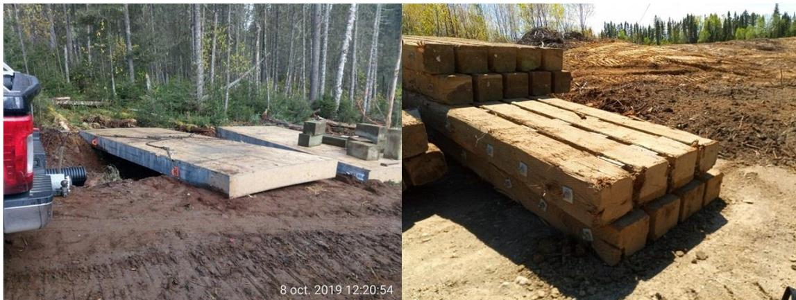
**Figure 3.5.1 : Éléments de tablier de conception constitués de bois lamellé-collé (gauche, site Boisaco, 8 octobre 2019, Côte-Nord) et de poutres de bois interreliées (droite, site T25-02, 6 juin 2019, Lanaudière).**
