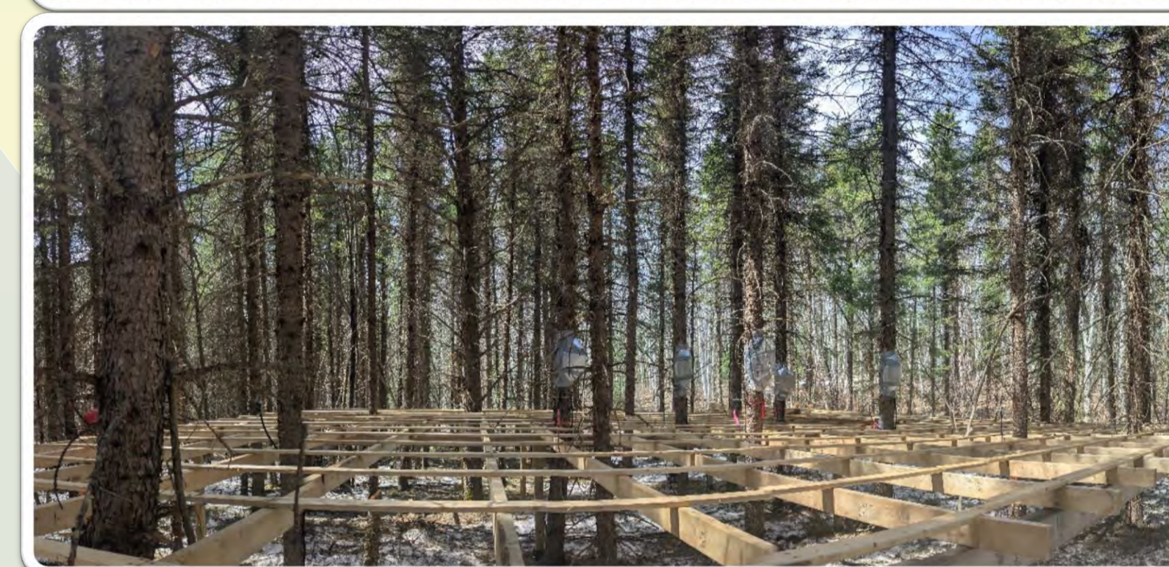
Photos du dispositif WaterDisp en cours d'installation, Valentina Buttò, Mai 2026
