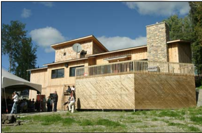
Une partie des locaux de la station de la FERLD
