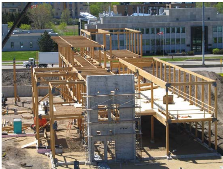
Le Pavillon Gene-H.-Kruger lors de sa construction (photographie : Benoît St-Pierre)
