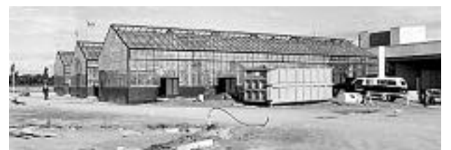
Construction des serres adjacentes au CFL.
