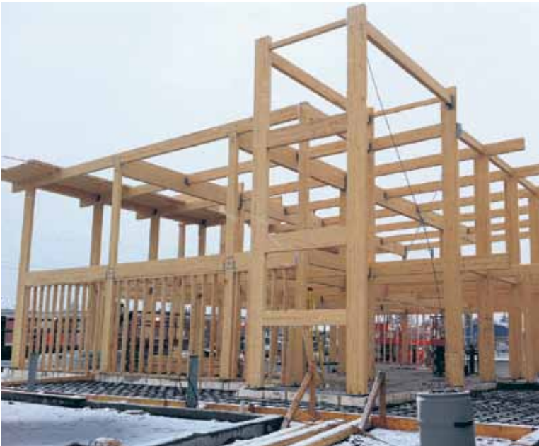
Construction d'un bâtiment utilisant le système poteaux-poutres en bois lamellé-collé. – Photo : Joël Sirard
