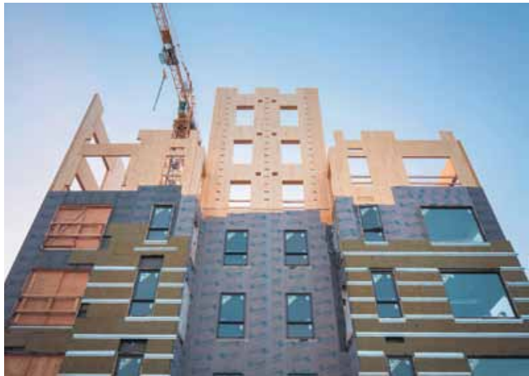
Construction d'un bâtiment utilisant le système de panneaux massifs en bois lamellé-croisé. – Photo : Stéphane Groleau
