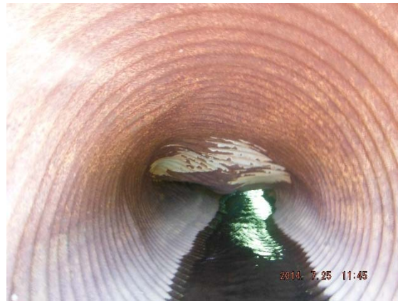
Déformation – tuyau écrasé
