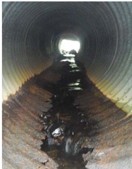
Figure 6 - Ponceaux avec radier entièrement corrodé
