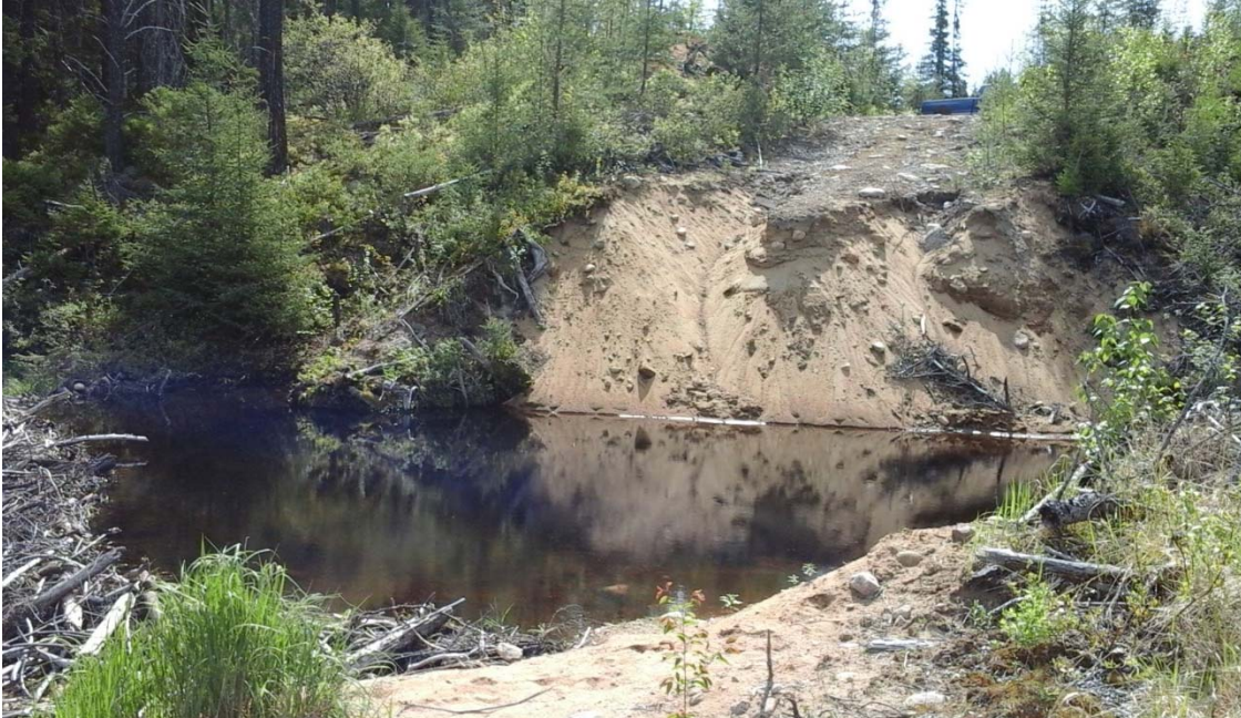
Figure 16 - Traverse de cours d'eau lessivée
