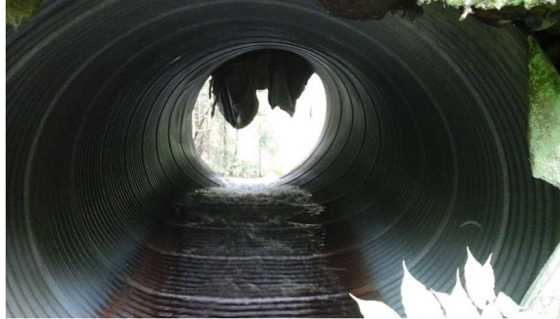
Déformation – tuyau ovalisé
