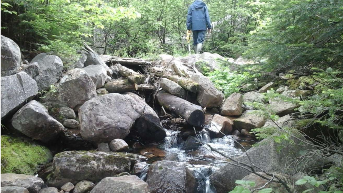
Figure 17 - Libre circulation du poisson entravée par un ponceau de bois affaissé
