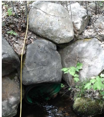
Figure 21 - Ponceau en plastique endommagé à cause d'un enrochement
